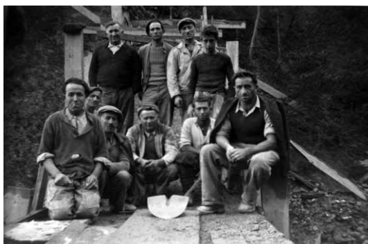
Travaux de captage au Chastelaret le 30/09/1950.
