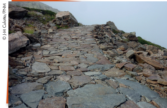
Ancienne piste militaire de Valescura (col de la Lombarde) : Les armées utilisaient des techniques de dallage similaires à celles utilisées lors de la construction des voies romaines.
